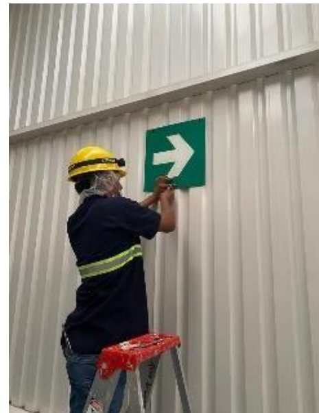
Anexo 16. Instalación de señalización de ruta de evacuación.
