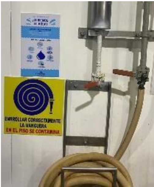
Anexo 5. Instalación de afiche sobre el cuidado del agua en mangueras.
