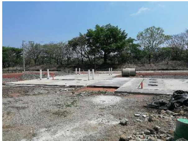
Fotografía 1 - Inspección a estación de servicio, Agua Blanca, Jutiapa.
