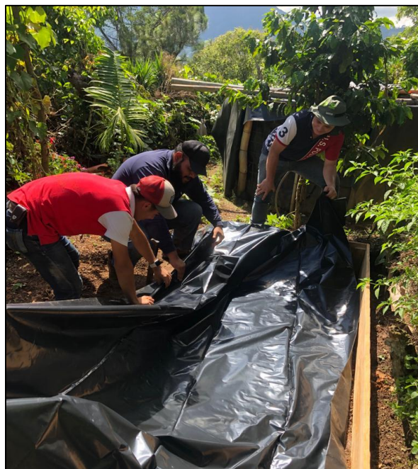
Fotografía 3. Apoyo en la construcción de estructura almacenadora de lenteja de agua
