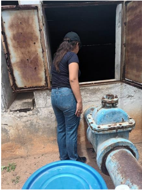
Figura 13. Toma de muestra de agua de los tanques de distribución
