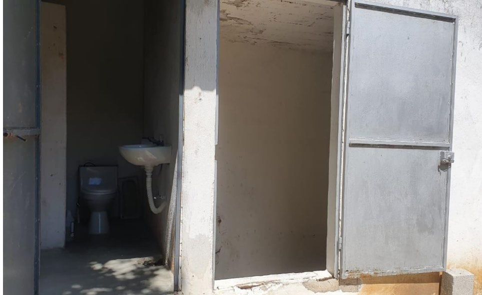
Puerta de ingreso a sótano de bodega de acopio temporal de desechos y área de baño, Hospital Megamédica.
