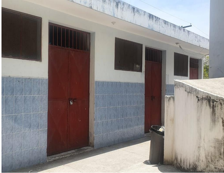
Área de acopio de Hospital Regional con áreas separadas según tipo de desechos.
