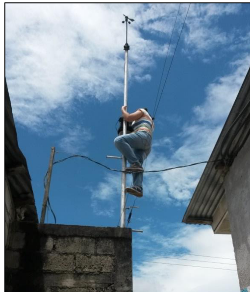
Fig 4. Mantenimiento a la estación meteorológica de Olopa.
